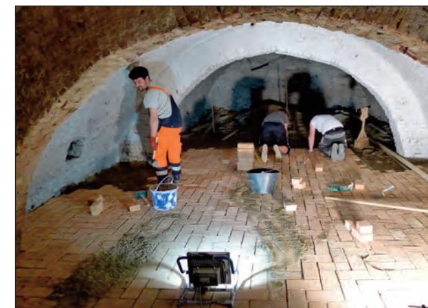
Trockenlegung und Ausbau des Kellers. Er soll zukünftig als Aufenthalts- und Partyraum genutzt werden. Foto: Wolfgang Weigl
